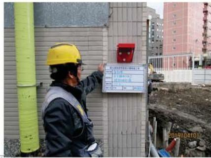
宿舍棟 安全觀測施工-建物傾斜儀自主檢查
